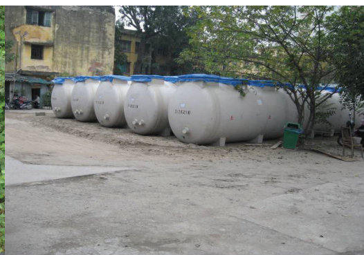
Hình PL3-5: Chuẩn bị lắp đặt hệ thống xử lý nước thải AAO
