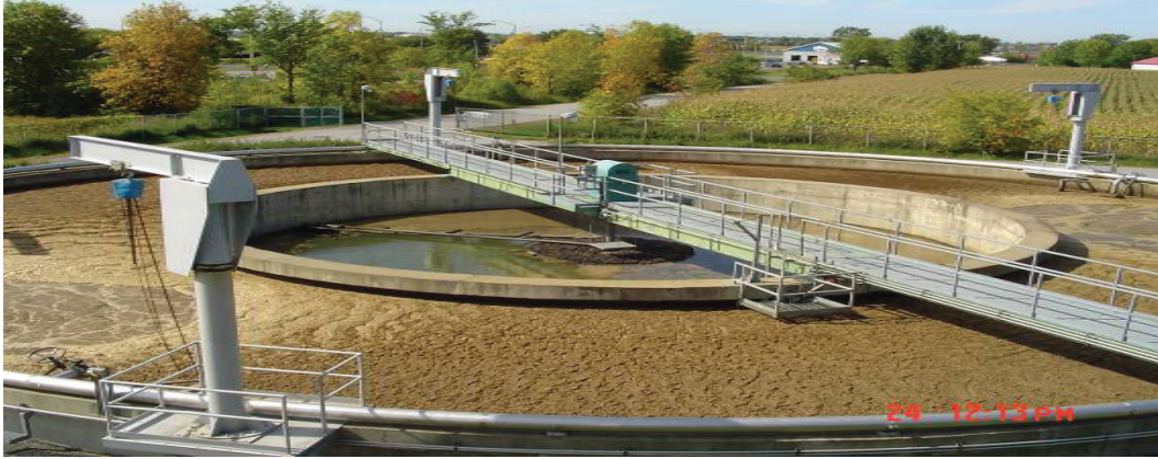
Hình 1-9: Bể hiếu khí thổi khí kéo dài
