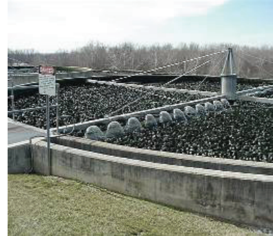
Hình 14. Sơ đồ cấu tạo bể lọc sinh học
