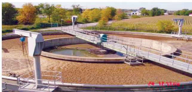
Hình 15. Aerotank thổi khí kéo dài
